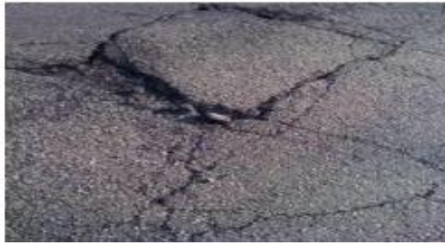
Gambar 3.9 Mengembang ( Swell ) Sumber : Bina Marga No. 03/MN/B/1983
