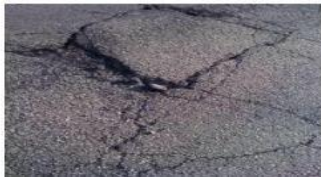
Gambar 3.9 Mengembang ( Swell ) Sumber : Bina Marga No. 03/MN/B/1983
