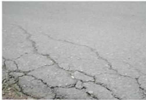
Gambar 3.5 Retak Pinggir
