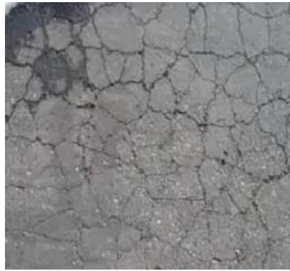
Gambar 3.10 Retak Susut
