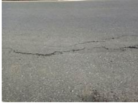
Gambar 3.4 Retak Memanjang
