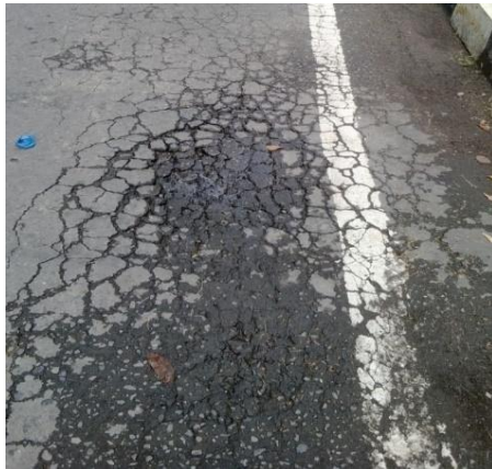
Gambar 3.2 Retak Kulit Buaya
