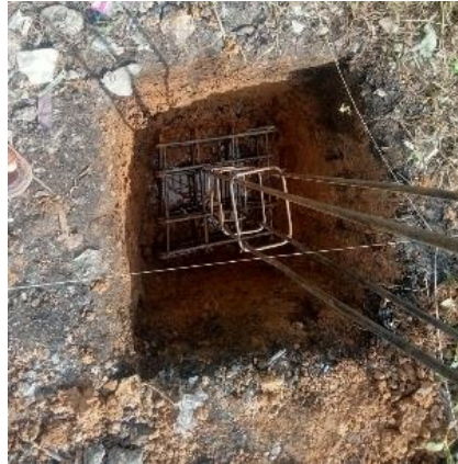
Gambar 2. 2 Pondasi Tapak
