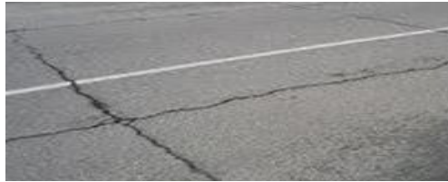
Gambar 3. 15 Retak Reflektif Sambungan
