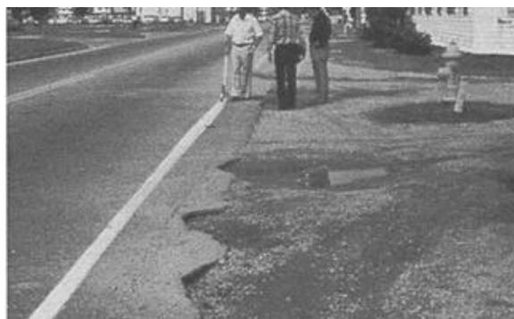
Gambar 3. 5 Retak Pinggir
