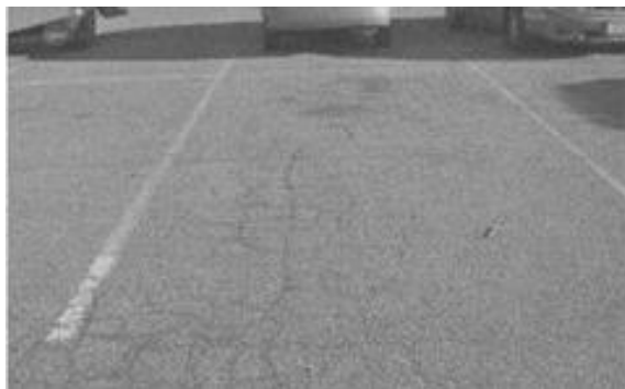
Gambar 3. 2 Retak Kulit Buaya
