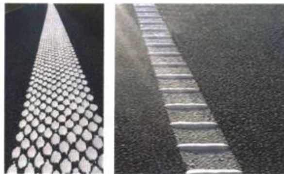
Gambar 3. 14 Marka Paku Sumber: Pusat Litbang dan Jembatan
