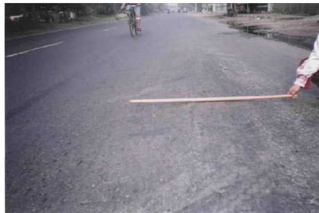
Gambar 3. 19. Mengembang Jembul ( Swell ) Sumber : Bina marga no.03/MN/B/1983
