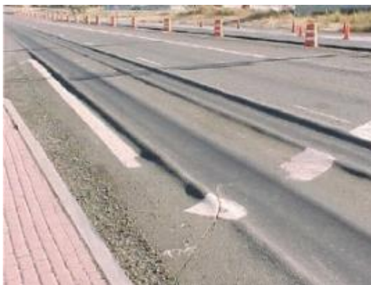
Gambar 3. 1 Retak Alur
