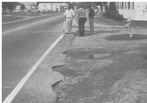
Gambar 3. 3 Retak Pinggir
