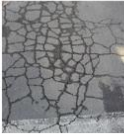
Gambar 3. 2 Retak Kulit Buaya
