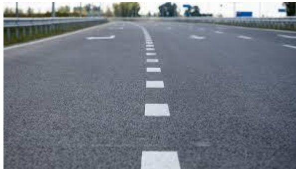
Gambar 3. 2 Marka Jalan Garis Membujur Garis Putus-Putus
